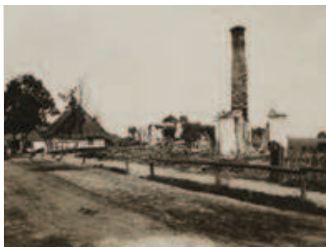
Spalone budynki po majowej zagładzie w Wereszczyźnie.
