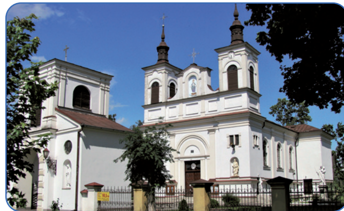
Kościół pw. św. Trójcy w Dubience, fot. J. Tworek
