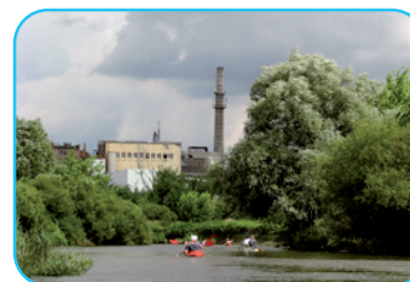
Budynki cukrowni w Strzyżowie, fot. J. Tworek
